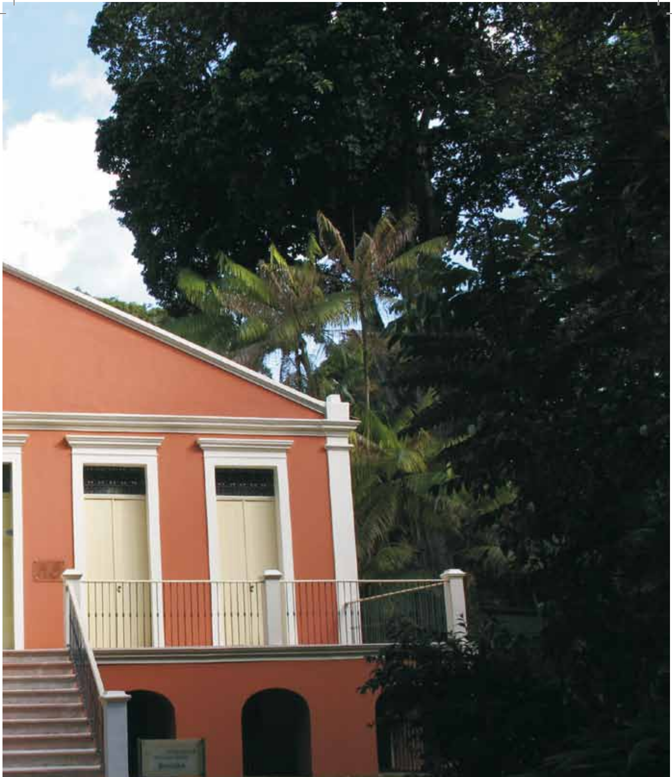
Pavilhão Domingos Soares Ferreira Penna, Museu Paraense Emílio Goeldi/MCTI. Conhecida como Rocinha, a edificação foi construída em 1879 – e o nome homenageia o fundador da instituição. Atualmente, o prédio abriga as salas de exposições de longa duração e temporárias, o Centro de Visitantes, o Núcleo de Visitas Orientadas ao Parque Zoobotânico, a Ouvidoria, miniauditório e salas multiuso para oficinas educativas.
