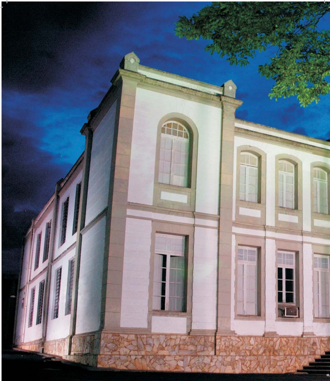
Prédio Central do Campus I da Universidade Federal do Triângulo Mineiro - UFTM, Uberaba, MG. Construído no começo do século XX, abrigou inicialmente a Penitenciária de Uberaba. Em 1954, o prédio foi doado pelo governador Juscelino Kubitschek para acolher a Faculdade de Medicina do Triângulo Mineiro - FMTM, criada no ano anterior. Em 2005, a Faculdade foi transformada em Universidade. Foto: Cláudio Pessoa/ Acervo UFTM.
